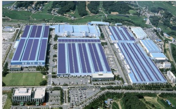
• 르노 삼성 자동차 부산공장 태양광 발전 주차장 공사
