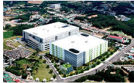
포스코 영지물류센터 신축공사
