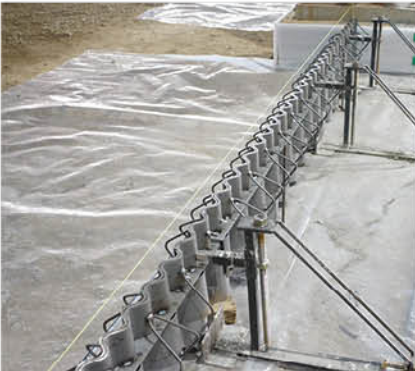
4 시공 줄눈 설치
