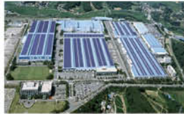
르노삼성 자동차 부산공장 태왕광 발전 주차장 공사
