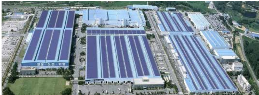
르노삼성 자동차 부산공장 태양광 발전 주차장 공사
