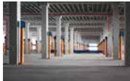
덕영 휴매드 물류창고 신축공사
