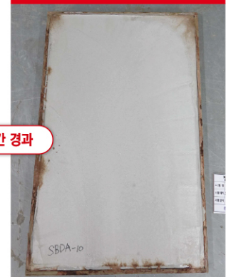
신통방통 층간소음 솔루션 균열 미발생
